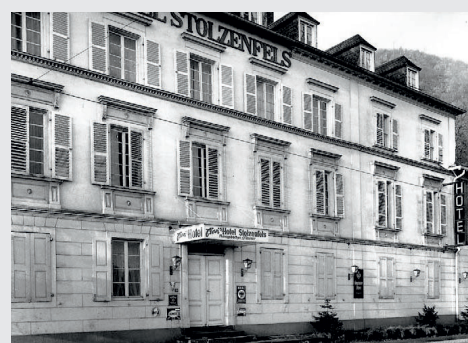
Amtsgebäude Kapellen-Stolzenfels Koblenz (1948)
